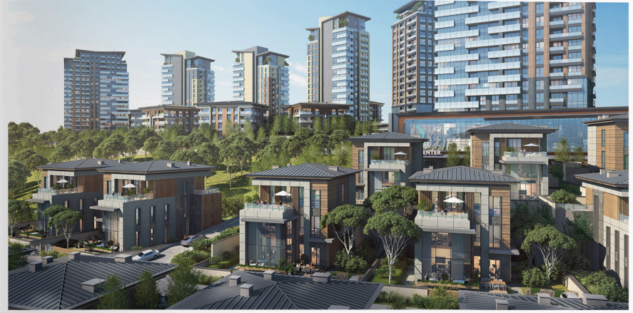
OYAK İNŞAAT-OYAK KENT BAŞAKŞEHİR
